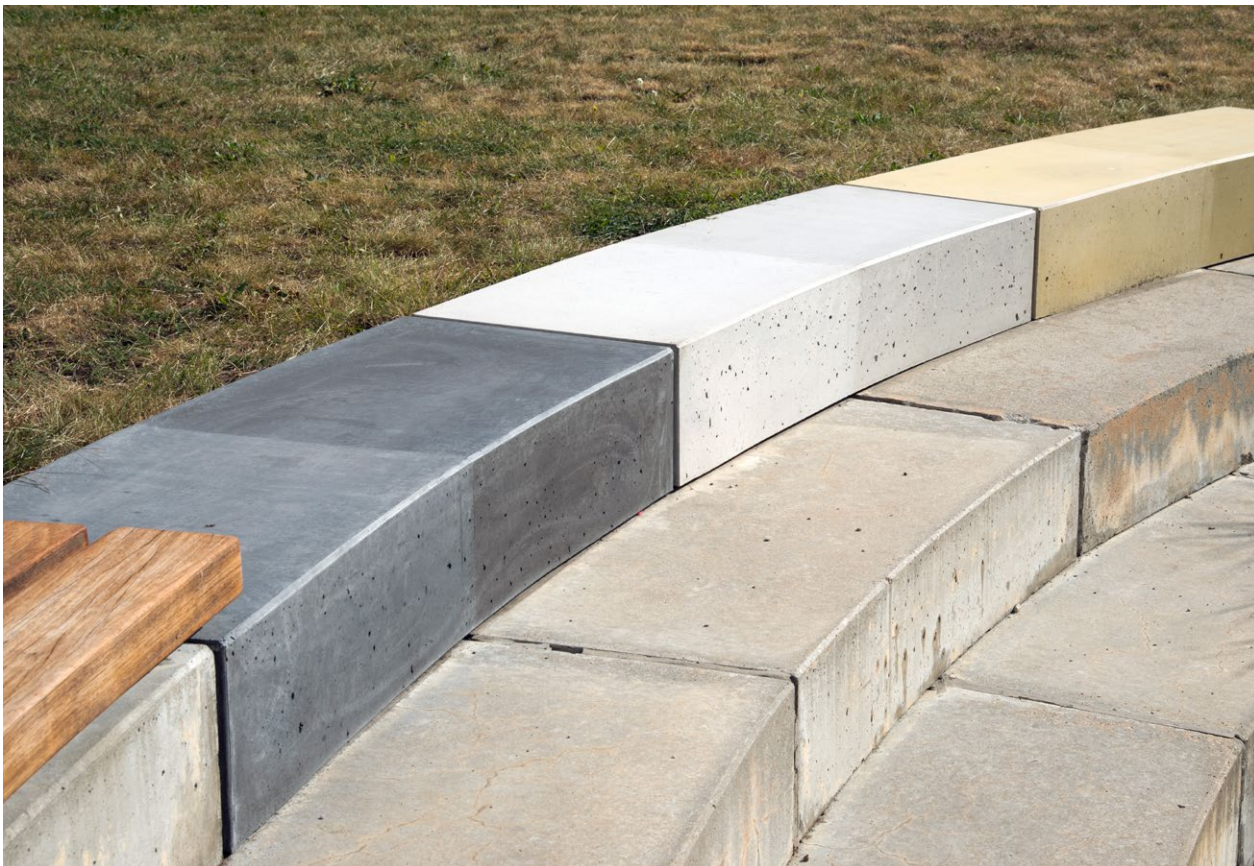
Die Sitzsteine aus pigmentiertem Leichtbeton in einem Innenhof der BAM. Der Beton enthält leichte Gesteinskörnungen, die thermisch aus Mauerwerkbruch hergestellt wurden.
