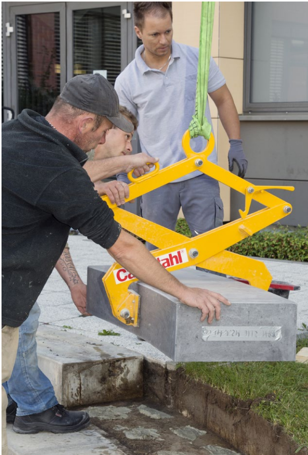
Einbau eines Sitzsteines aus Leichtbeton im Innenhof der BAM.
